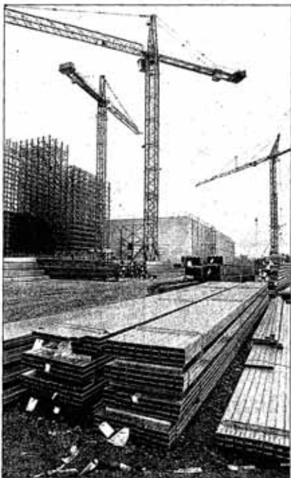
„Wir liegen voll im Zeitplan“: In nur wenigen Wochen wuchs die gewaltige Baustelle aus dem Rheindürkheimer Boden.
