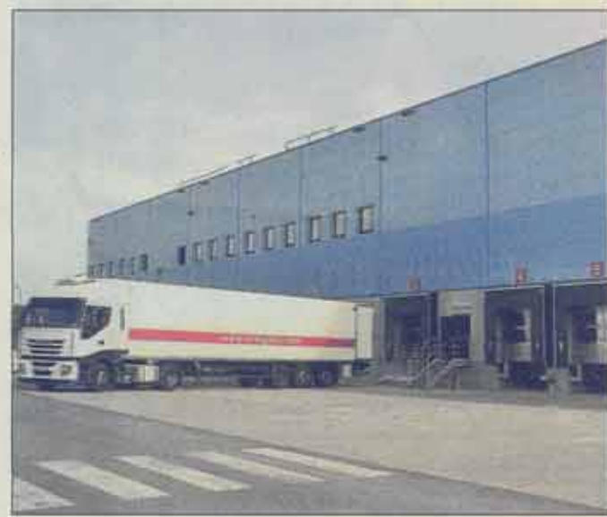
Fünf Lastwagen können gleichzeitig abgefertigt werden.
